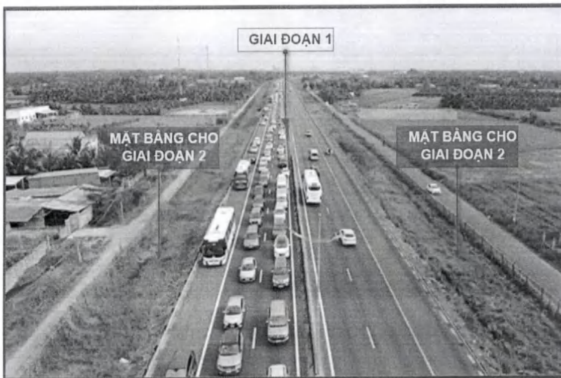
Hình 1: Hiện trạng đoạn Hồ Chí Minh – Trung Lương
